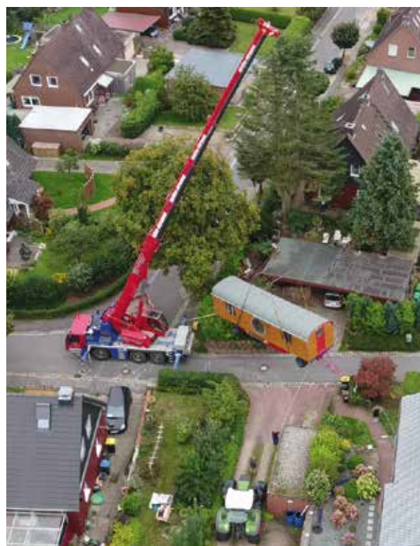
Ein Kran hebt den 10 m langen und 7.800 kg schweren Wagen um die zu enge Ecke.
